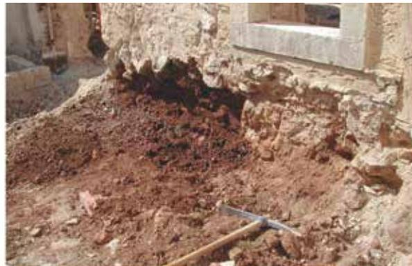
As paredes exteriores e mestra são de alvenaria de pedra diversificada assentes com argamassa de cal nas faces e com terra no interior. Não tem fundações.
